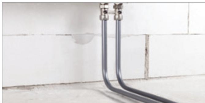
Подключение отопительного прибора с помощью универсальной трубы RAUTITAN stabil
